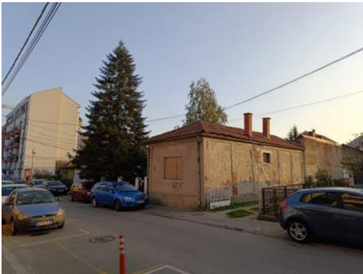
Slika 2 - Postojeći objekti predmetnog kompleksa uz Ulicu Tanaska Rajića
